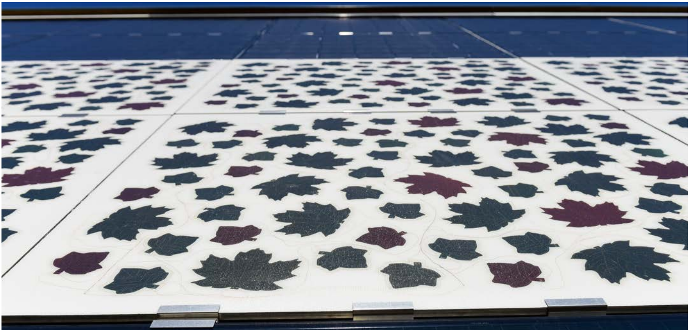
Photovoltaikmodul im Detail: Die Pilotfassade aus dem Forschungsprojekt hat ein optisch ansprechendes Design und erzeugt Solarstrom direkt an der Gebäudehülle.
