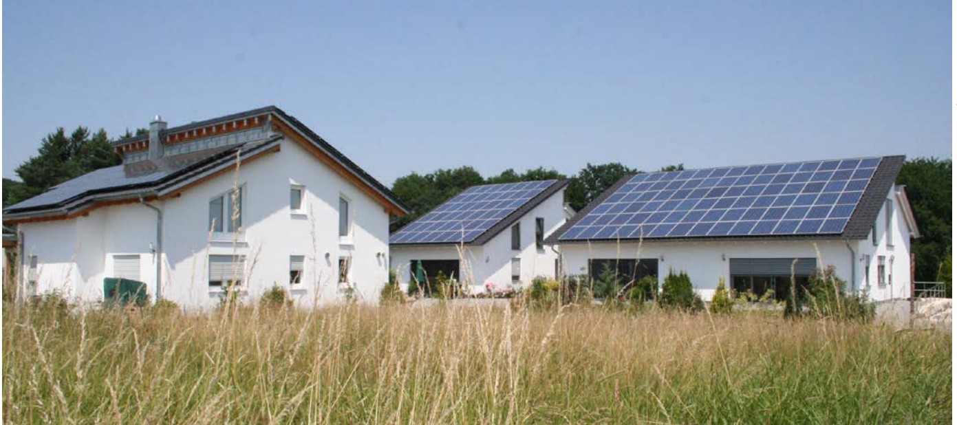
Klimafreundliche Energieversorgung in Wüstenrot: Die erforderliche thermische und elektrische Energie wird größtenteils aus erneuerbaren Energien (Erdwärme und Sonnenenergie) gewonnen.
