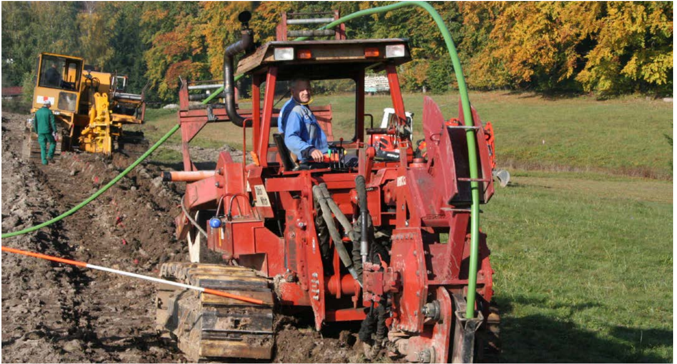
Die Agrothermiekollektoren werden mit einem Kabelpflug in den Boden eingepflügt, sodass die Fläche weiterhin landwirtschaftlich genutzt werden kann.
