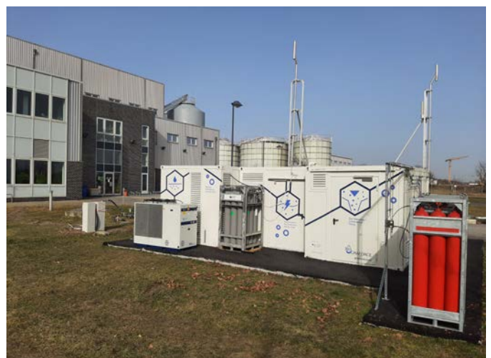
Die Pilotanlage in Waßmannsdorf: Hier wird mittels Plasmalyse aus industriellem Schmutzwasser Wasserstoff erzeugt.
