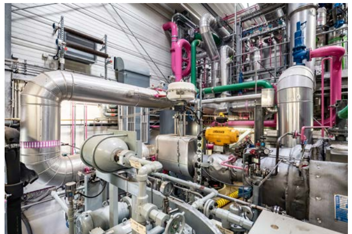
Ein Labyrinth aus Rohren: Die Geothermieranlage in Bruchsal pumpt pro Sekunde 30 bis 70 Liter salzhaltiges Thermalwasser an die Oberfläche.
